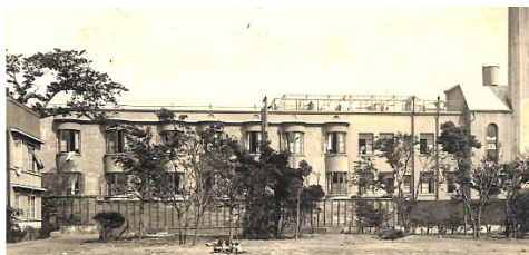
昭和9（1934）年 附属淀橋病院病棟
